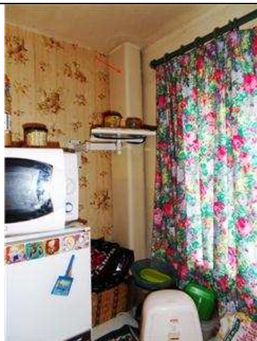
009 - Appartements - Cuisine LOT 0101 PH14 : amiante ciment
